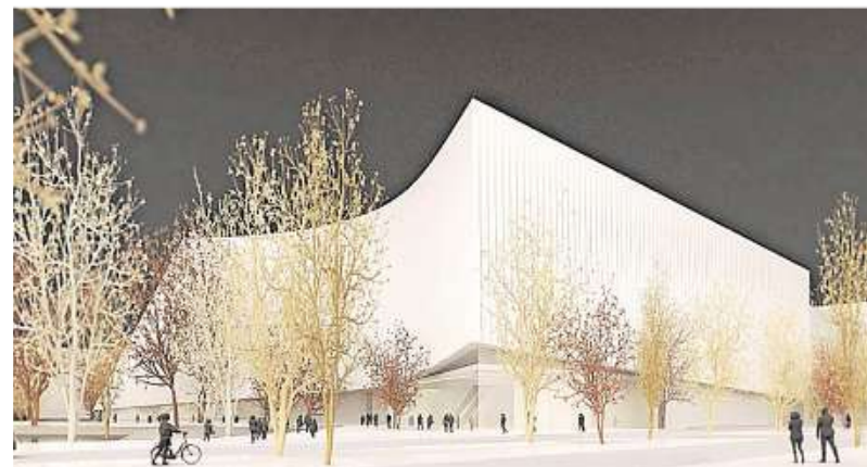
Zum Weiher Landskrone haben die Planer von Snøhetta eine geschwungene Fassade entworfen. BILD: SNØHETTA
