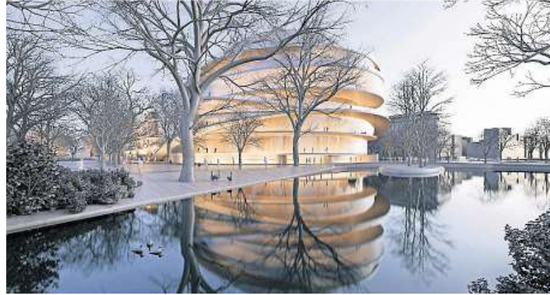
Begehbare Rampen an der gerundeten Nordfassade kennzeichnen den Ingenhoven-Entwurf für die Heinrich-Heine-Allee. BILD: INGENHOVEN/WEST 8
